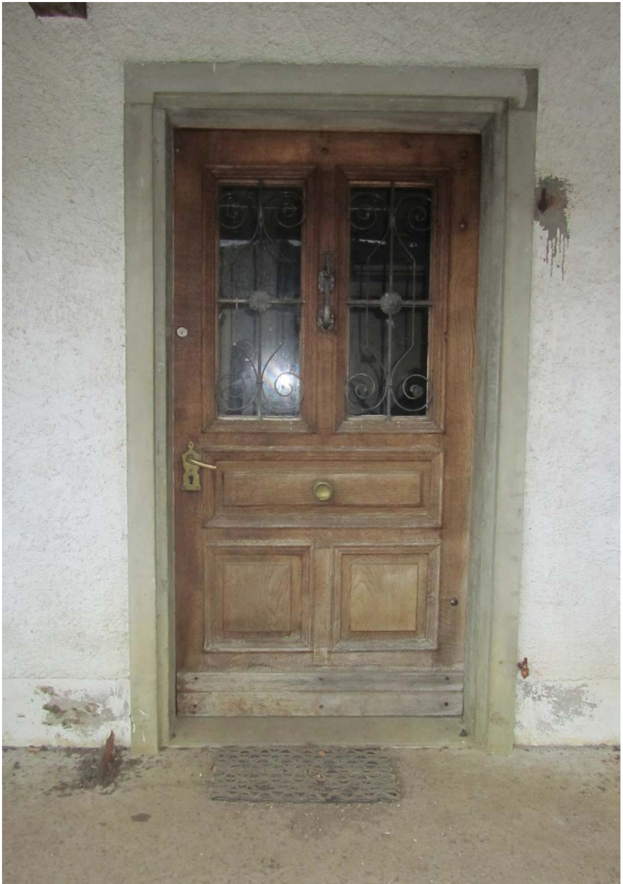
Une porte très certainement plus vieille que le bâtiment lui-même.
