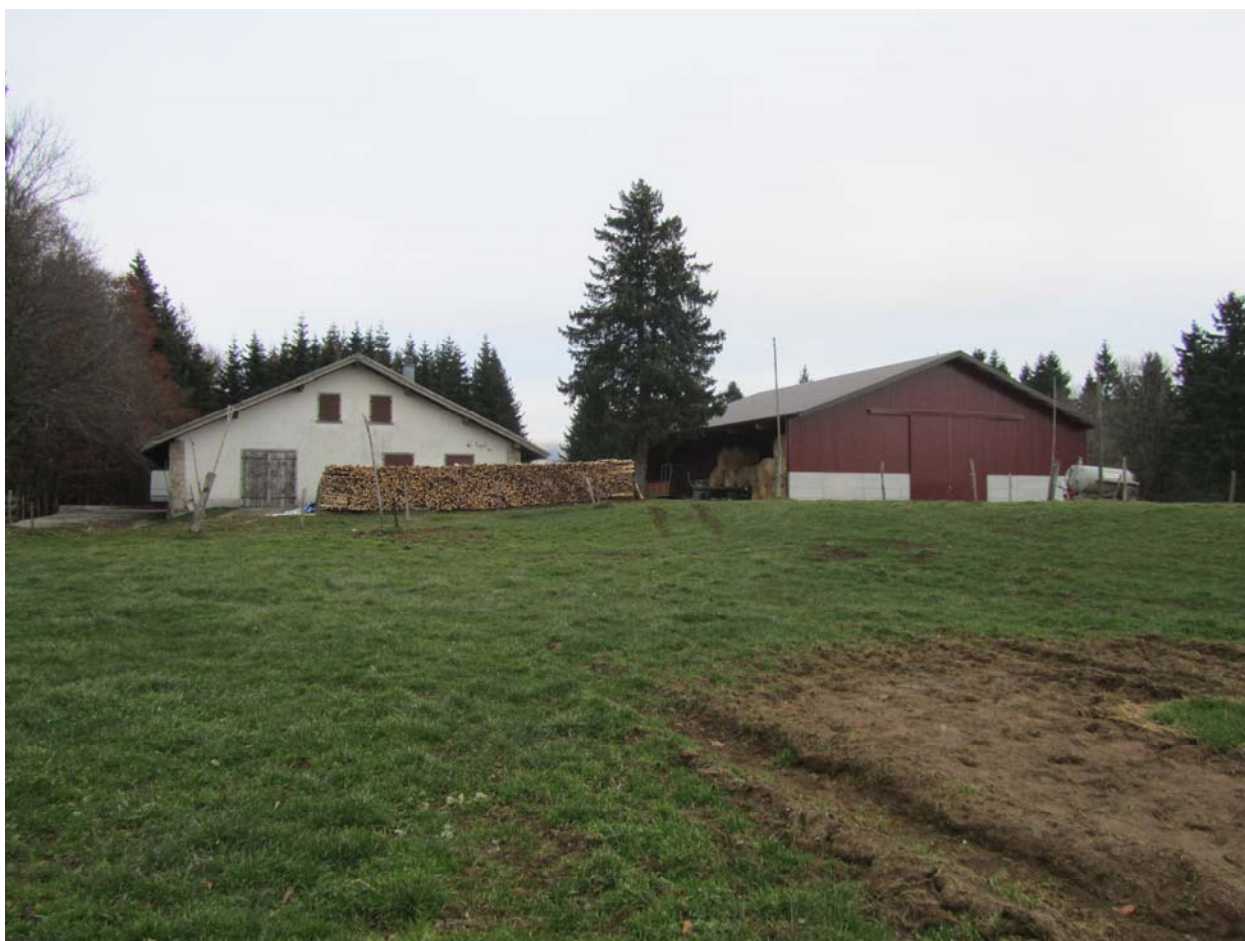
Les deux bâtiments de l'alpage du Muguet. Le hangar de droite avait croulé sous le poids des ans et de la neige, ici reconstruit de frais.
